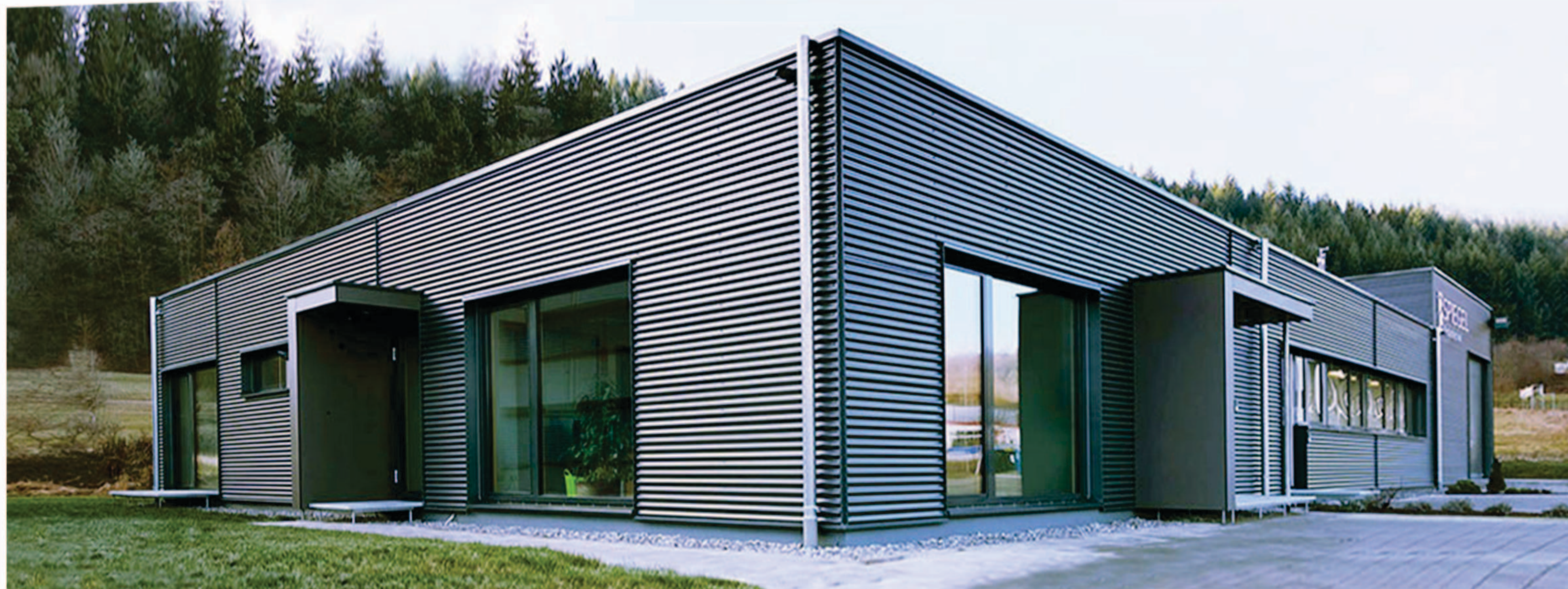
Die Fassade täuscht: Die neue Gewerbehalle von Spiegel Medizintechnik wurde fast nur mit ökologischen Materialien errichtet.
